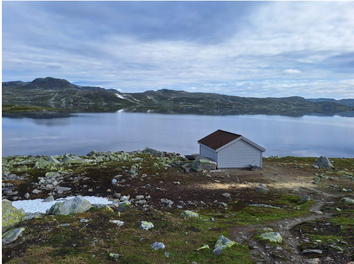
Figur 4: Nauste på Belebu vart rive og eit nytt vart sett opp på same stad i somar. Eit veldig bra arbeid som vart utført på dugnad.
