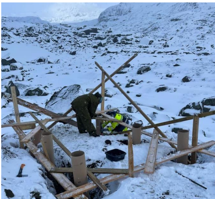
Figur 3: Støyping av søyler til uthuset vart utført i oktober (Foto: H.Bruleite)
