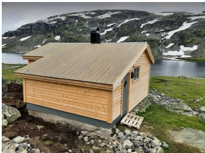
Figur 3: Ninive ferdig renovert utvendig (Foto: THH Tjemsland)
