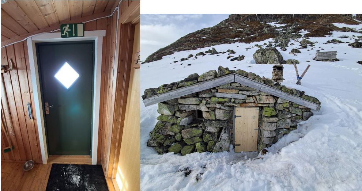
Sten-Rune Jensen har montert ny inngangsdør på Kolven og Vegarhovdlægeret. Foto: HF, Sten-Rune Jensen
